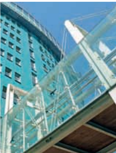
E/D/E: Brücke zwischen Tradition und Zukunft
