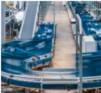
Die Förderstrecke im Zentrallager Wuppertal wurde ausgebaut.
